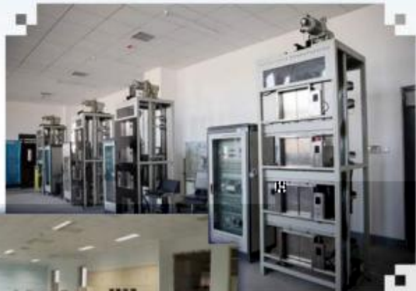
智能电梯安装调试 维护训练场所
